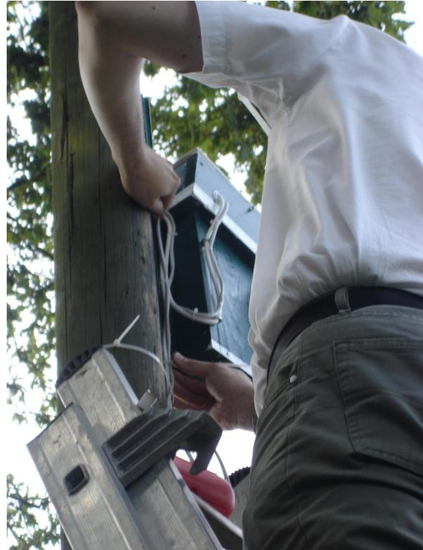
bereits mehrere Nistgelegenheiten, welche jährlich voll ausgebucht sind. An diesem Standort verzichten wir auf den Einsatz von Funknetz und legen oberirdisch Kabel für 220V sowie Ethernet (Netzwerk).
